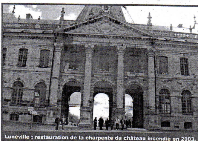
Lunéville : restauration de la charpente du château incendié en 2003.
