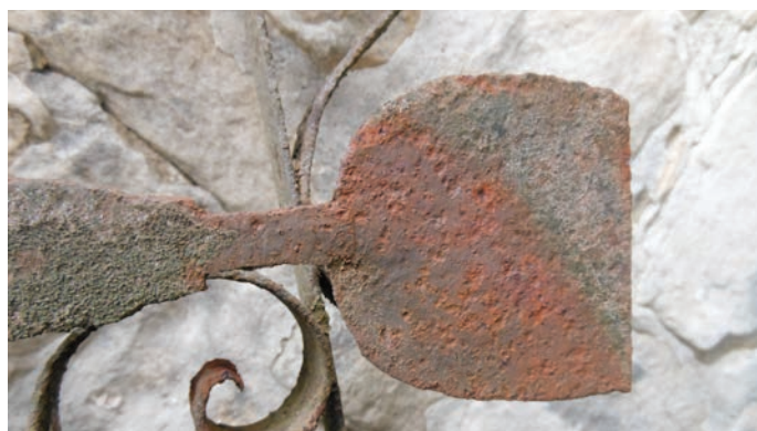
► Croix de sépulture de Pierre Chazet, vers 1882, cimetière de Noisy-sur-Ecole (Seine-et-Marne). La croix est composée d'une hampe et d'une traverse certainement forgées, les rinceaux sont des bandes de fer peut-être également forgées qui sont rivetées sur leur support. Les outils sont identifiés comme suit (à partir du sommet et dans le sens des aiguilles d'une montre) : un niveau-équerre, une truelle à maçonner dite « truelle grosse », un riflard, une truelle brettée appelée également berthelet et un cinquième élément manquant (hauteur de l'ensemble : 177 cm, largeur : 92 cm ; en ce qui concerne le niveau-équerre : hauteur : 16,5 cm, largeur de la base : 32,5 cm) 1 . Photo J. Hantraye, 2015.
