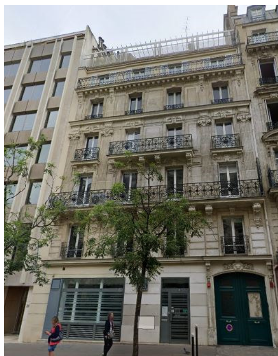
Répartition par mois selon les métiers pour le chantier du la rue du Faubourg-Saint Honoré
